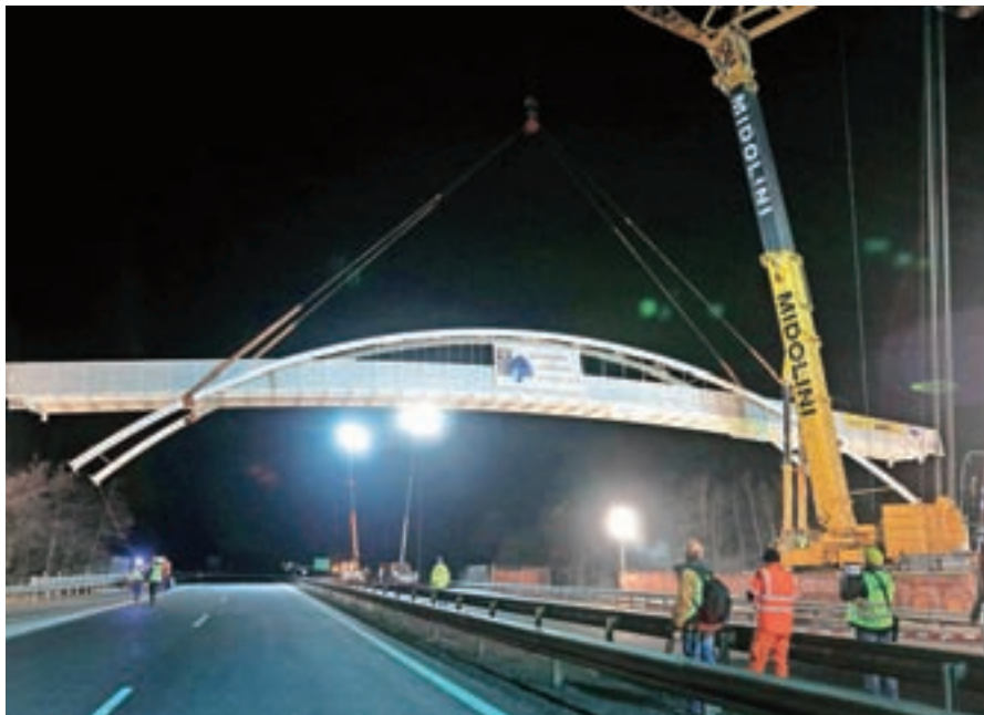
Nameščanje 58 ton težkega nadvoza čez avtocesto pri Voklem
