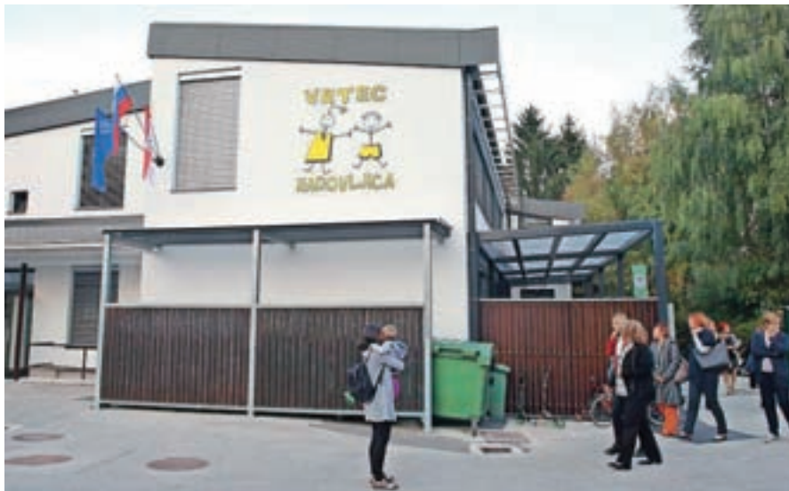
Jeseni je bila zaključena energetska sanacija radovljiškega vrtca.
