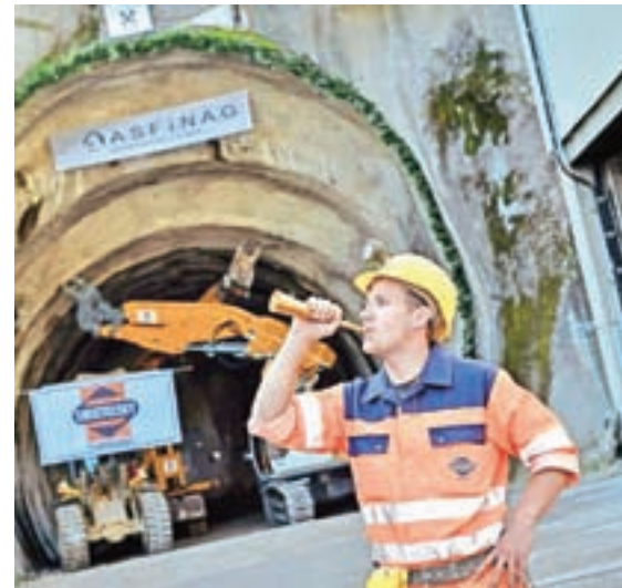
Avstrijci so že začeli vrtati drugo cev predora Karavanke.
