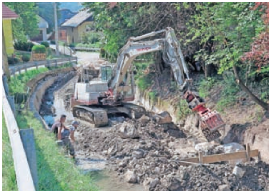
Začela se je regulacija potoka Bela.
