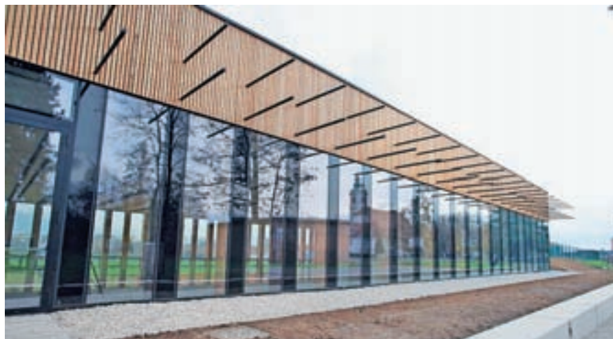
V Stražišču je zgrajena nova, težko pričakovana telovadnica.
